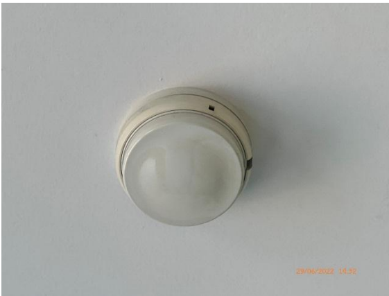
ภาพที่ 57 อุปกรณ์ตรวจจับความร้อนอัตโนมัติ
