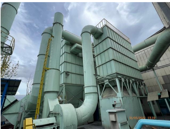
ภาพที่ 11 ปล่องระบบดักฝุ่นจากบริเวณพื้นที่เทอาหลอม
